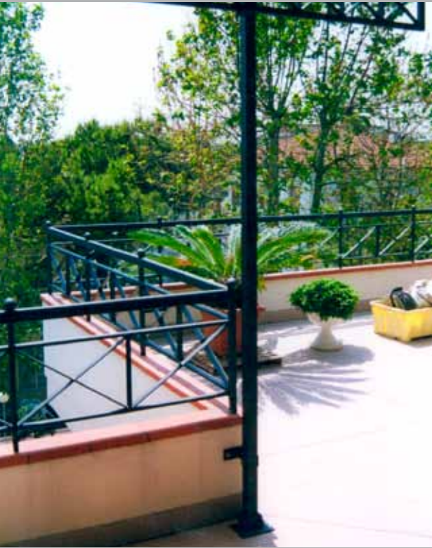
Doppio fissaggio muretto/ringhiera. Double système de fixation parapet/barrière
