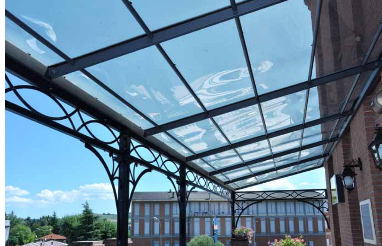
Pergola Novecento con tetto in policarbonato. Pergola Novecento avec toit en polycarbonate.
